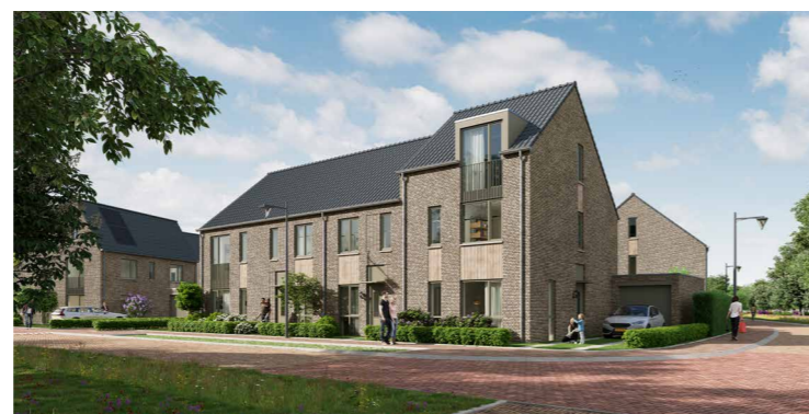
Hoek- en middenwoningen - D24 t/m D27 48 Plattegrond D24 50 Plattegrond D25 46 Plattegrond D26 52 Plattegrond D27 44
