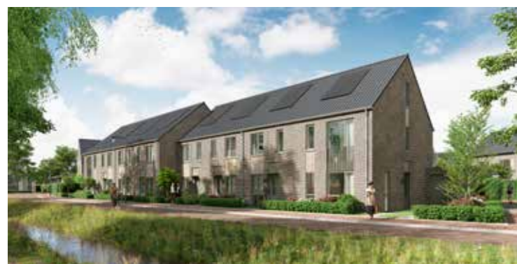
Hoek- en middenwoningen - D16 t/m D23 Plattegrond D16 Plattegrond D17, D19 & D21 Plattegrond D18, D20 & D22 Plattegrond D23
