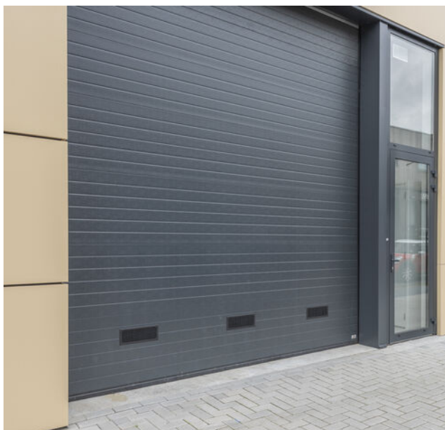
Overheaddeur van 4,5 meter hoog en 4 meter breed.
